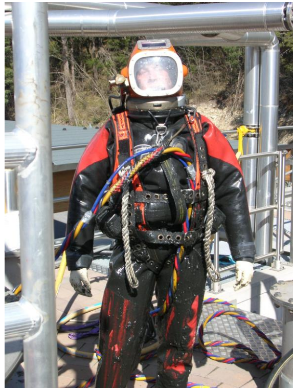
Abb. 2: Faulturmtaucher bei der Räumung des Faulturms an der Kläranlage Zirl 2009.
